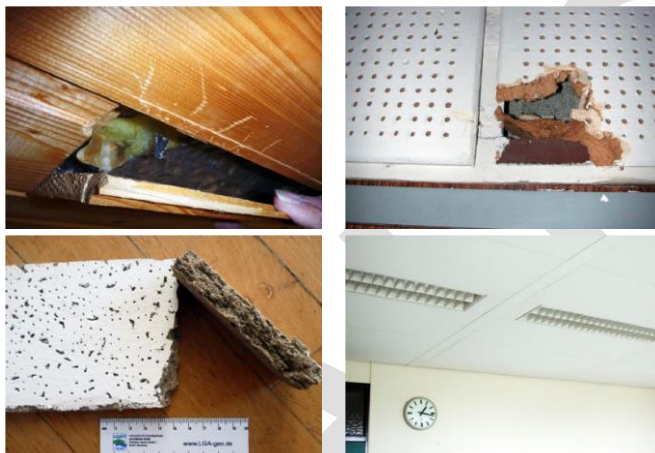
Linksboven: Minerale wol achter geprofileerd houten plafond Rechtsboven: Man Made Minerale vezels (MMMMF)-bevattende plafondtegels Linksonder: akoestisch plafondpaneel Rechtsonder: plafondpaneel ("Wilhelmi" panelen)
