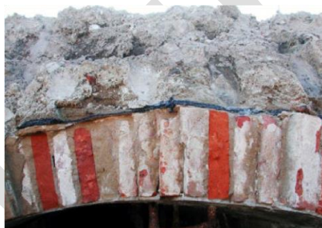
Links: Zwarte coating Rechts: Zelfklevende afscherming op een gewelf
