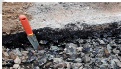
Linksboven: Dilatatievoeg, teerhoudend Rechtsboven: Teerhoudende zwarte laag op teerhoudende voorgespotten grindbasislaag Linksonder: asfaltschotsen Rechtsonder: afrastering met golfplaten asbest
