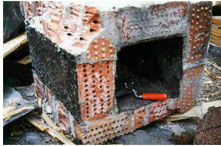
Links: open haarddeur met Asbestkarton en asbestkoord Rechts: Doorsnede via een open haard
