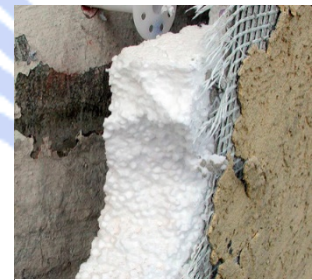
Polystyreen isolatiemateriaal in een buitenisolatie composit systeem
