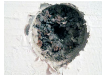
Veel vervuilende stoffen zijn alleen te vinden door gerichte exploratie: hier: verborgen teercurkisolatie achter een muurpleister
