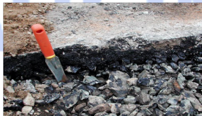
Linksboven: Dilatatievoeg, teerhoudend Rechtsboven: Teerhoudende zwarte laag op teerhoudende voorgespoten grindbasislaag Linksonder: asfaltchotsen Rechtsonder: afrastering met golfplaten asbest
